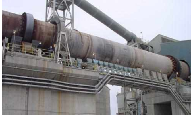
Şekil 16. Çimento üretim fabrikası döner fırın
