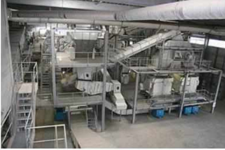
Şekil 31. Sofya MBT tesisi
